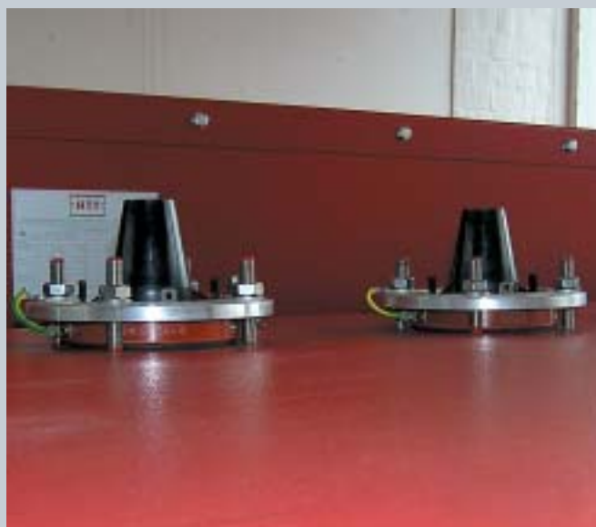
Присоединение кабеля по ВН сверху через проходной изолятор, по НН снизу через люк .
