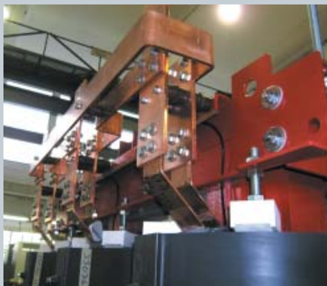
Присоединение по ВН и НН шинами сбоку через изоляционные пластины.
